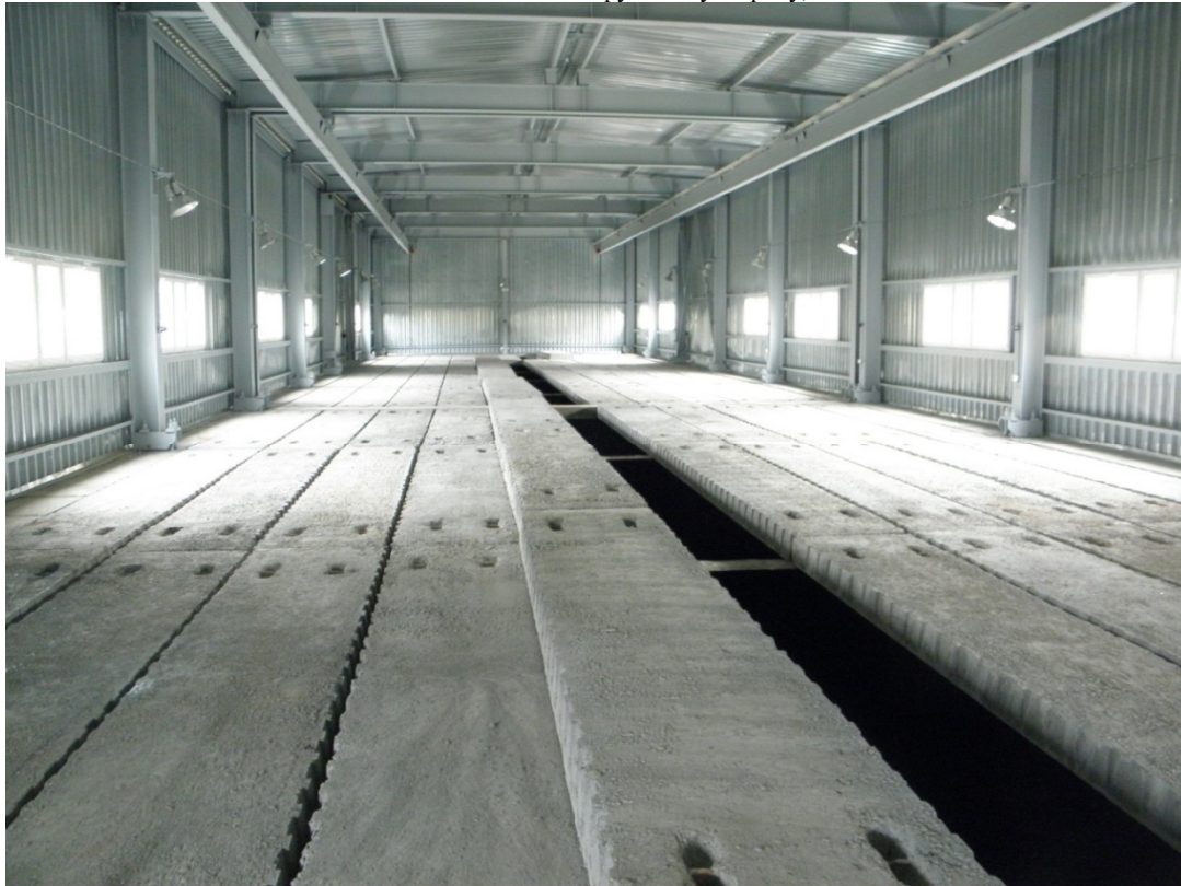
Рисунок 2.2.3.9 – Помещение хранилища радиоактивных отходов наземного типа
