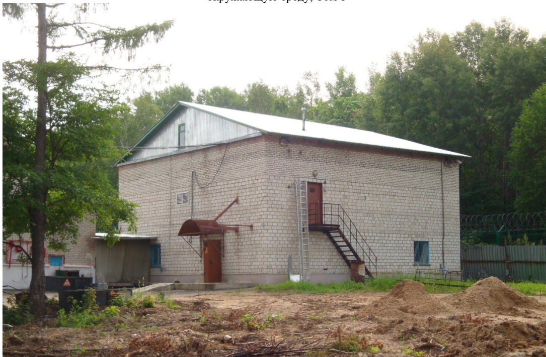
Рисунок 2.2.3.5 – Здание Комплекса по перегрузке ИИИ
