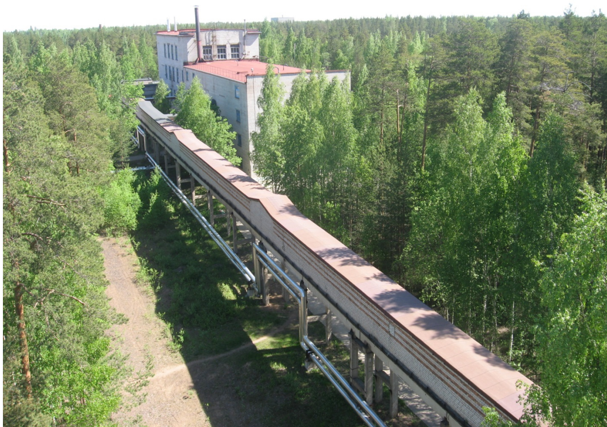
Рисунок 2.2.2.7– Переработка жидких радиоактивных отходов, здание 21
