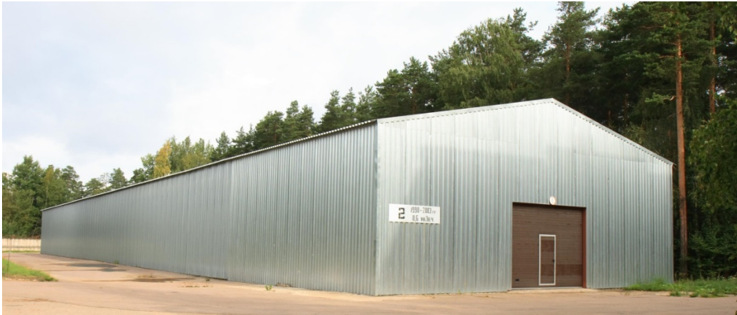
Рисунок 2.2.2.3 – Хранилище твердых радиоактивных отходов, здание 2
