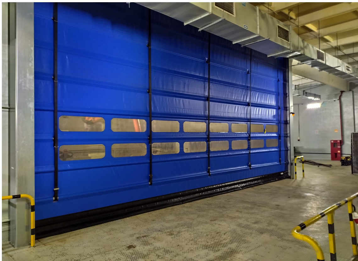
Рисунок 2.2.2.10 - Участок по обращению с радиоактивными отходами, размещенными в крупногабаритных контейнерах, здание 26.
