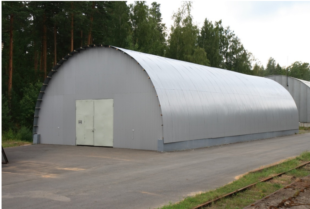
Рисунок 2.2.2.8- Площадка хранения производственных отходов, загрязненных природными радионуклидами, здание 28
