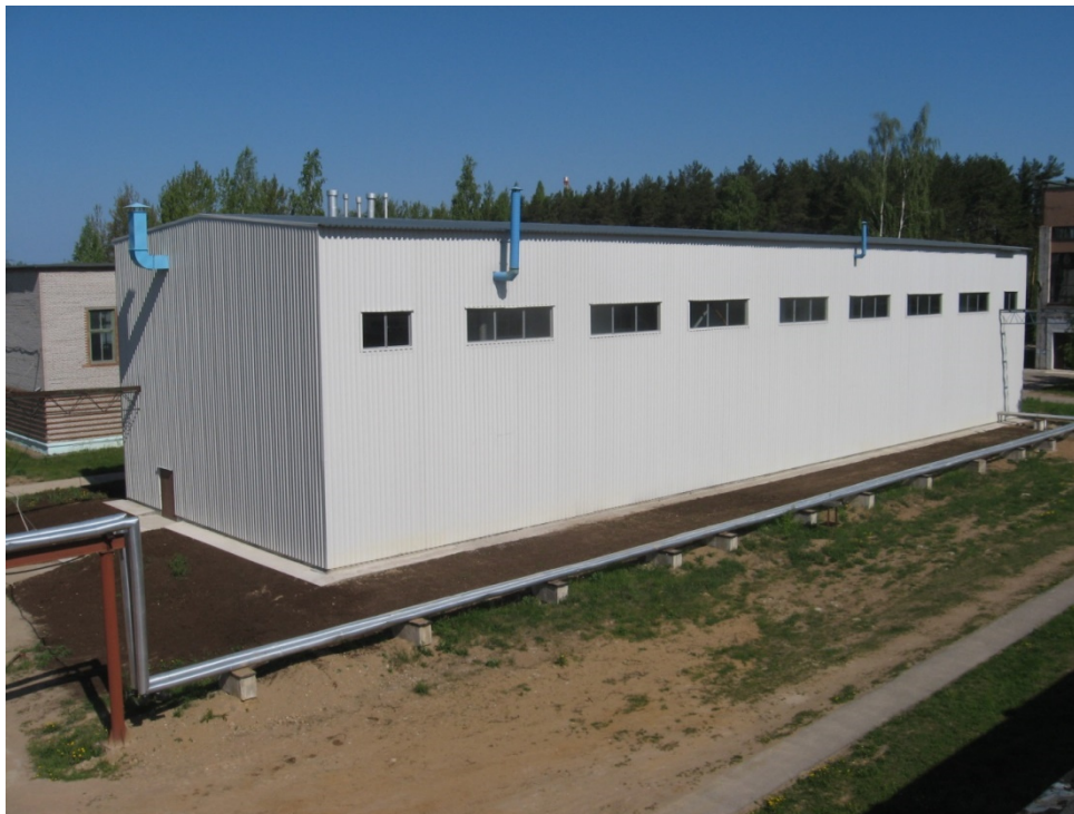
Рисунок 2.2.2.2– Хранилище твердых радиоактивных отходов, здание 1
