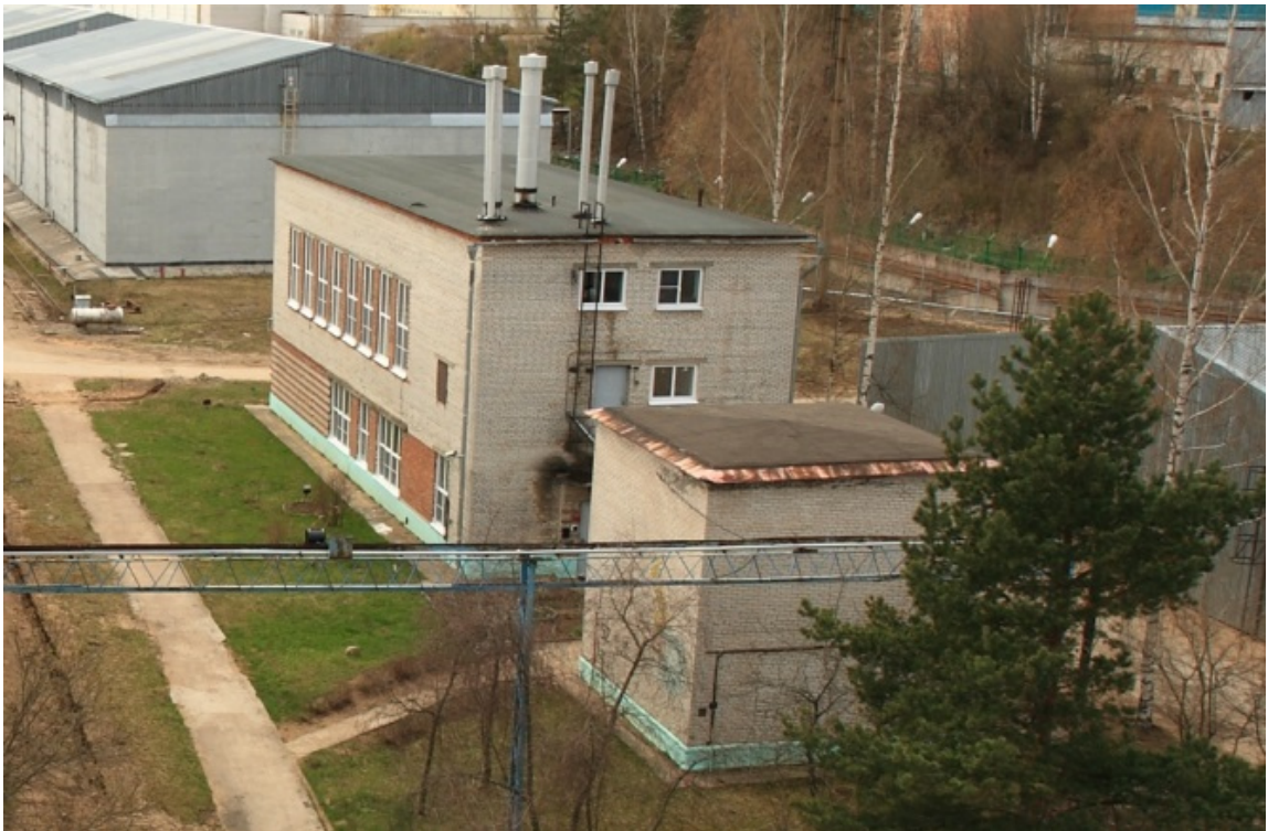
Рисунок 2.2.2.5 - Хранилище отработавших источников ионизирующего излучения, здание 17
