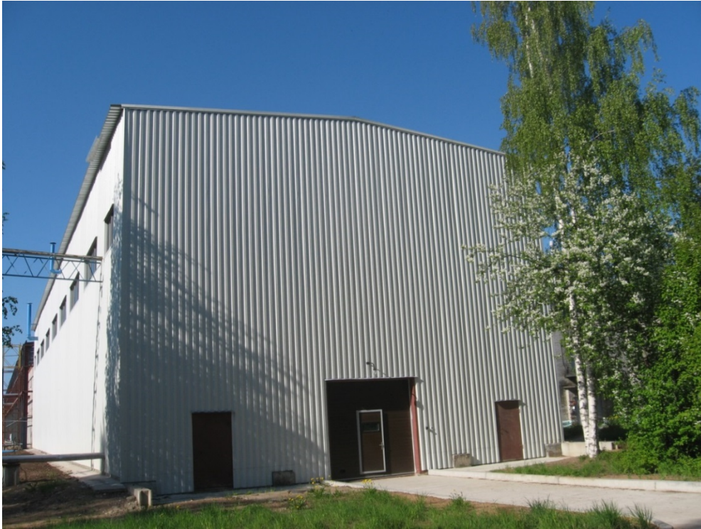
Рисунок 2.2.2.4- Хранилище твердых радиоактивных отходов, здание 14
