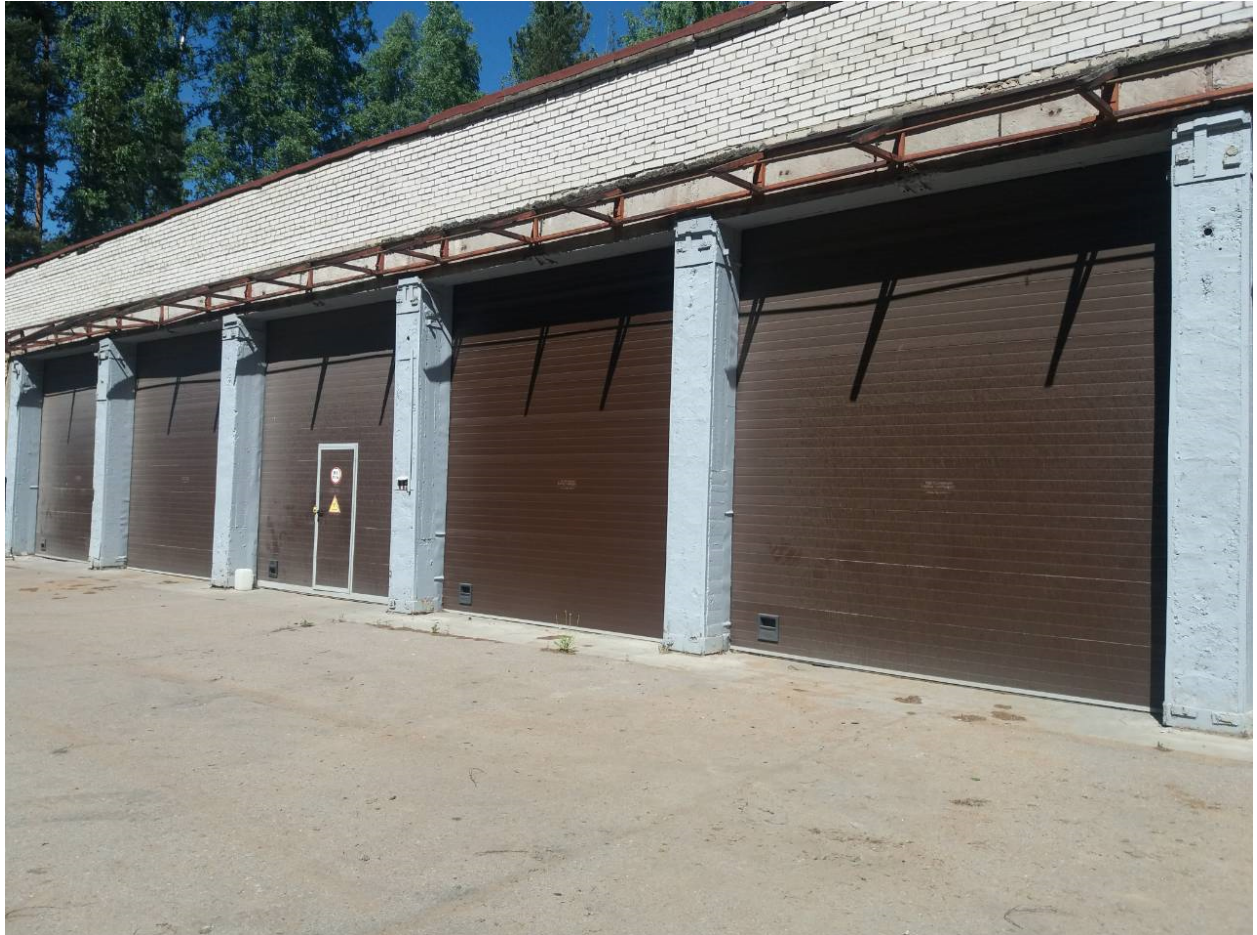
Рисунок 2.2.2.9 - Здание 26 (участок по обращению с радиоактивными отходами, размещенными в крупногабаритных контейнерах)
