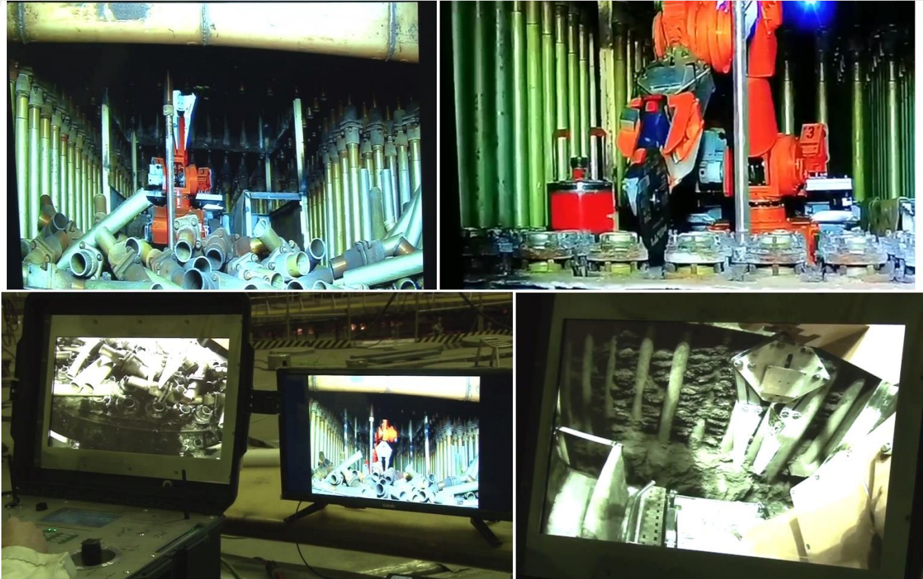
Испытания комплекса МРК-28 в реакторном пространстве ПУГР АДЭ-5: А – внешний вид МРК-28; Б – МРК на платформе при опускании в проем; В, Г, Д, Е – демонтаж и извлечение металлических элементов в проеме.
